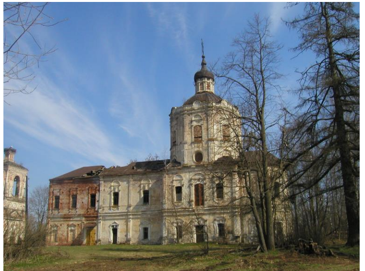
Фото 4. Знаменская церковь. Южный фасад
